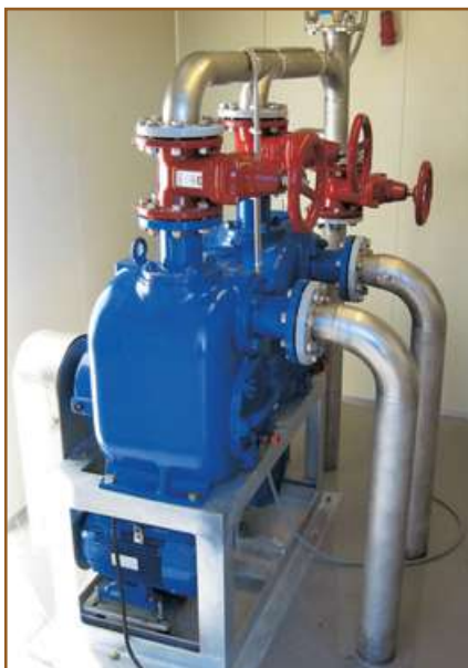
Station de relevage des eaux d'égout Station uitpompen van rioleringen Abwasser- Hebewerk
