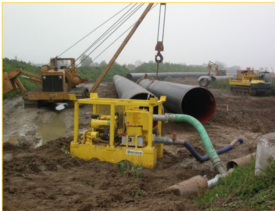
Drenaggio scavi per posa metanodotto Drainage des fouilles pour la pose de canalisation Drenaje de las excavaciones para puesta metanoducto
